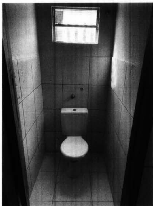
Imagem 10 – Execução do contrapiso e assentamento de revestimento cerâmico nas cabides dos banheiros e instalação de novos basculantes em todas as cabines dos banheiros.
