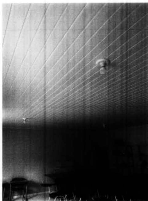
Imagem 6 – Instalação do forro pvc e pintura interna.
