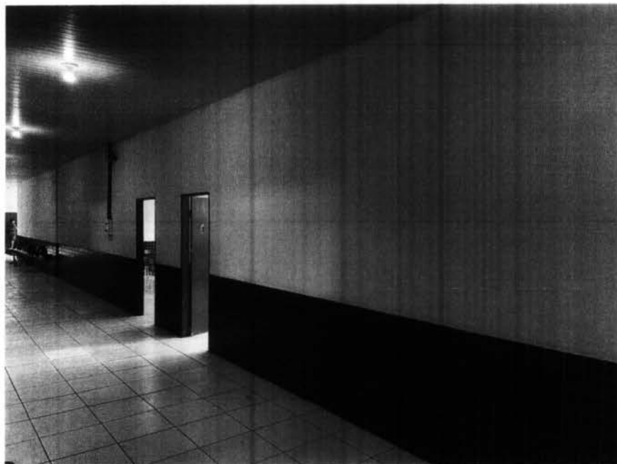
Imagem 4 – Pintura interna da escola e substituição de placas do revestimento 10x10 no corredor das salas.
