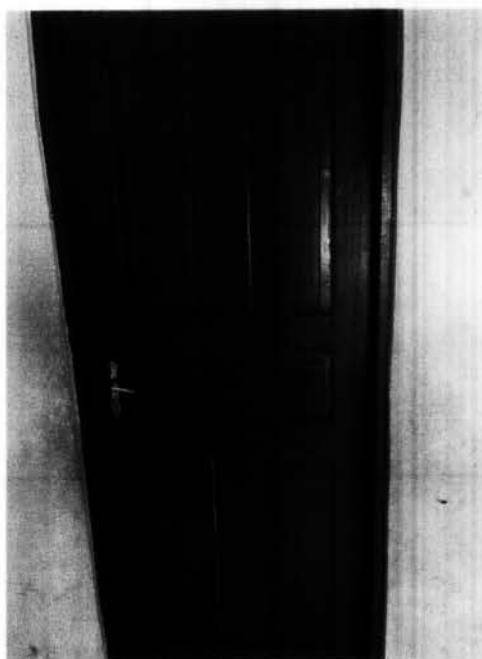
Imagem 5 – Pintura das esquadrias de madeira
